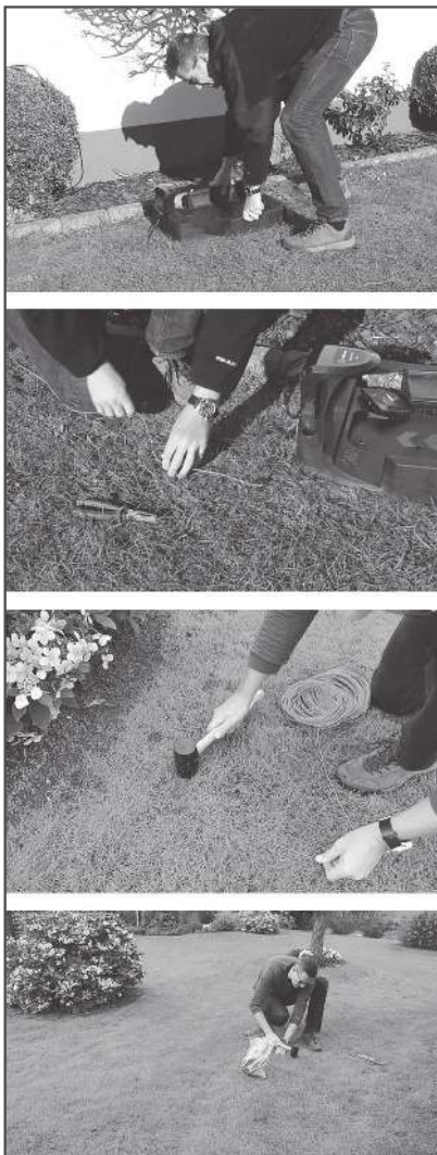
Рис. 7 Последовательность действий при установке зарядной станции
