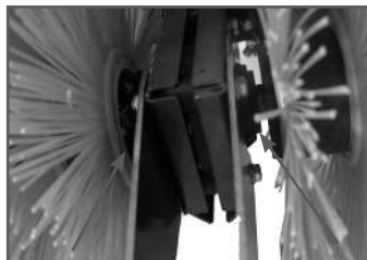
Рис. 4 Установка соединительных пластин крепления отвала
